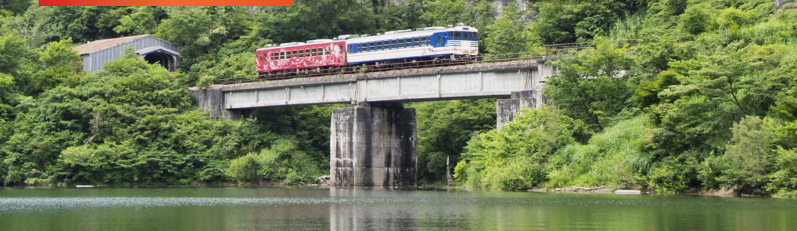
湖上からの只見線の列車(旧田子倉駅付近、7月撮影)
