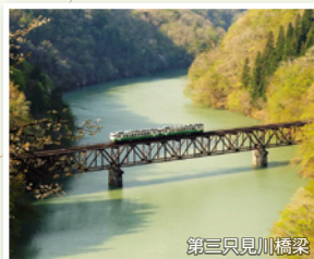
第三只見川橋梁
